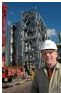
Jost Krüger vor dem Gerüst der neuen Desodorierungsanlage, die nächste Woche aufgebaut wird. Sie wird doppelt so hoch sein. Foto: A. Woitschütze
